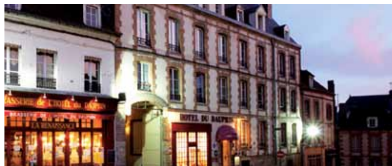
Avec l'aide d'un cabinet spécialisé, l'Hôtel du Dauphin peut financer sa modernisation, qui permettra un meilleur accueil des groupes.
